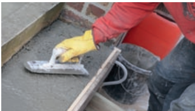
Horizontale vlakken afwerken met schuurbord
