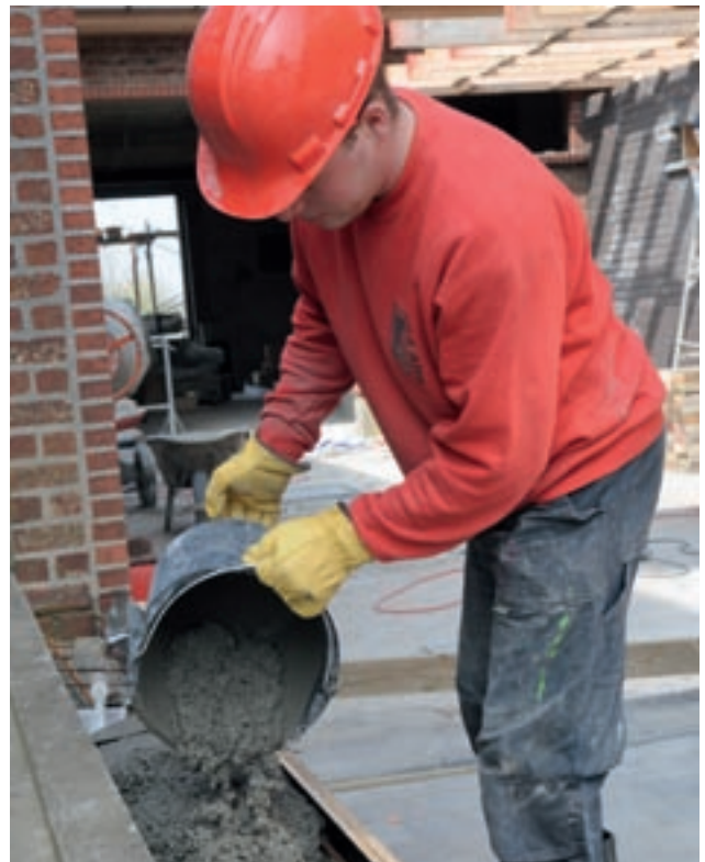
Stort beton niet van te grote hoogte
