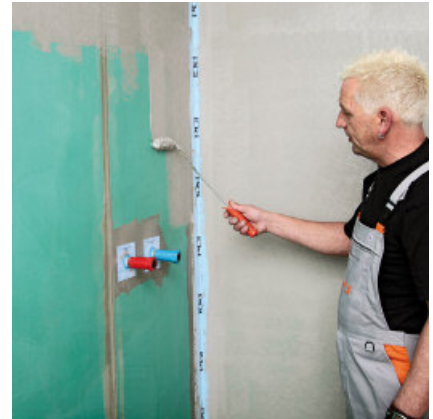
Vervolgens afdichtingsmateriaal erover smeren of spachtelen.
