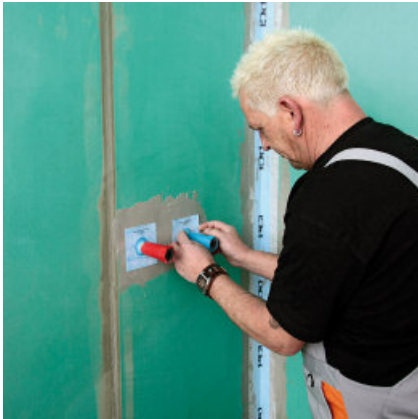
Het manchet voorzichtig over de stop op de pijp schuiven en verlijmen op het afdichtingsmateriaal.
