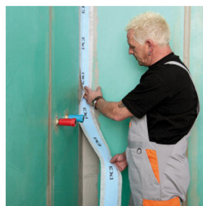
PCI Pecitape wordt ingebed in de verse waterafdichtingslaag.
