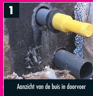
Tangit M 4082 Dichtsok is eenvoudig om de buis te wikkelen
