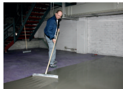
Met PCI Periplan Multi wordt een snel belastbare vloeregalisatielaag aangebracht
