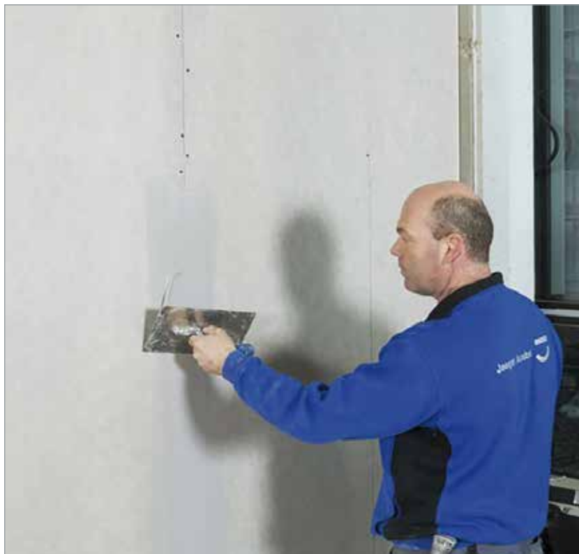
Afvoegen van Drystar Board met Drystar-Filler, in dit geval met wapening van Papierstrook.
