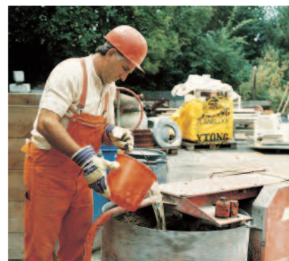
PCI Mischöl is een luchtbelvormende toeslag voor mortel, pleister en dekvloeren.
