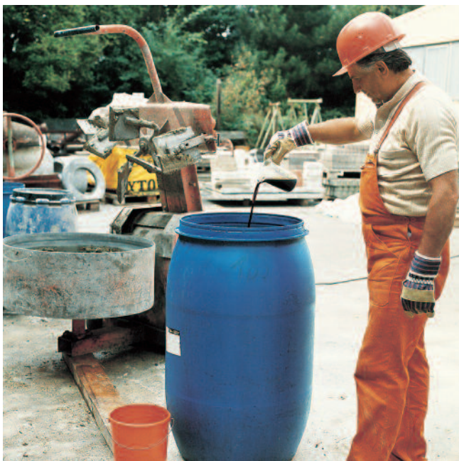
PCI Mischöl wordt aan het aanmaakwater toegevoegd.
