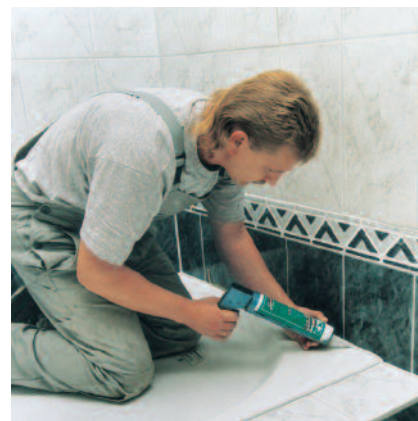
Hoek-, aansluit- en bewegingsvoegen elastisch afkitten.
