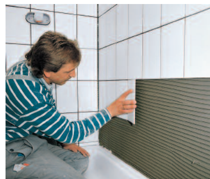
Met PCI FT Extra kunnen tegels op waterdichtingspasta PCI Lastogum worden gelijmd.
