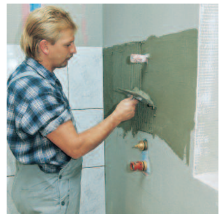
PCI FT Extra heeft een goed standvermogen. Tegels hechten meteen, maar kunnen nog gecorrigeerd worden.
