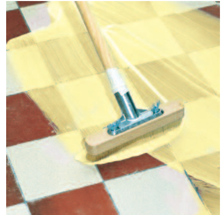
De primer met volledige dekking over de ondergrond verdelen door kruislings te werken.
