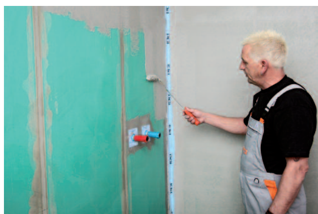
Vervolgens afdichtingsmateriaal erover smeren of spachtelen.
