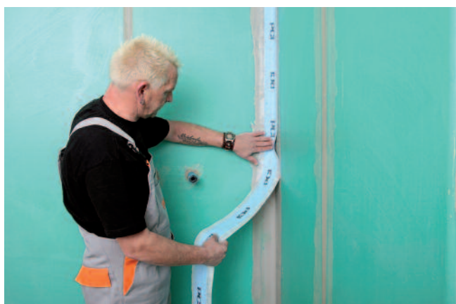
Vervolgens wordt het dichtband PCI PECITAPE 120 op de juiste plaats aangebracht en licht aangedrukt.
