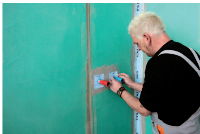
Het manchet voorzichtig over de stop op de pijp schuiven en verlijmen op het afdichtingsmateriaal.
