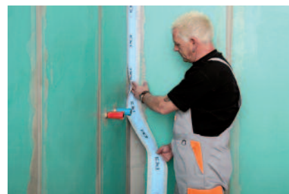
PCI Pecitape wordt ingebed in de verse waterafdichtingslaag.
