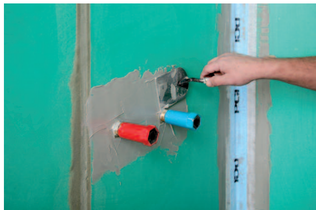
Ook bij het afdichten van waterleidingsbuizen met PCI PECITAPE 10 x 10 voldoende afdichtingsmateriaal aanbrengen.
