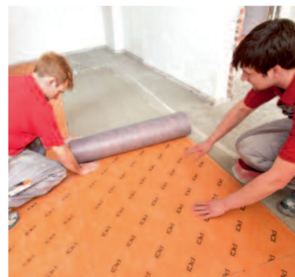
Keramiek kan op de afdichtings- en ontkoppelingsmat PCI Pecilastic U eenvoudig aangebracht worden.
