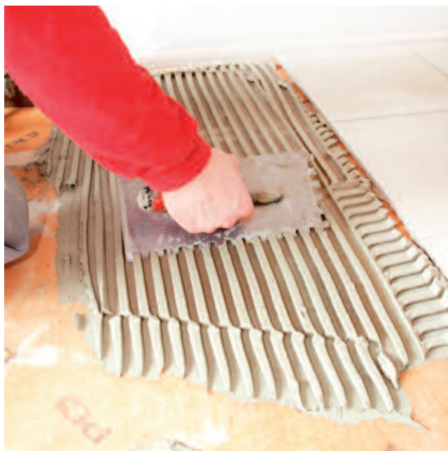
En met PCI NANOFLOTT LIGHT of PCI RAPIDFLOTT het nieuwe keramiek verlijmen.
